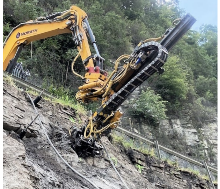
Zur Durchführung konnte nur kleine und leichte Gerätetechnik eingesetzt und von oben gearbeitet werden.
