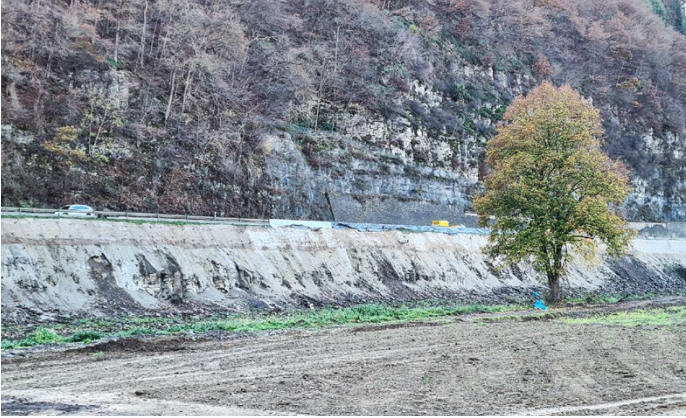
Auf einer Länge von ca. 400 m wurde eine Rückverankerung zur Böschungssicherung durchgeführt.
