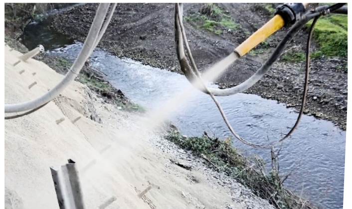
Die Schalddicke der Spritzbetonschale beträgt 25 cm bis bereichsweise 50 cm an Ausbrüchen.
